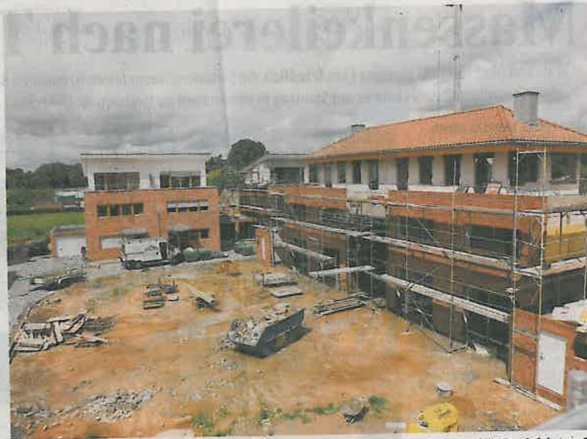
Die beiden größeren Häuser (rechts) ahmen die historische Situation nach. An ihrer Stelle stand die Toreinfahrt zur Fabrik . Die übrigen Häuser gruppieren sich um einen Innenhof. FOTO: MARKUS RICK
